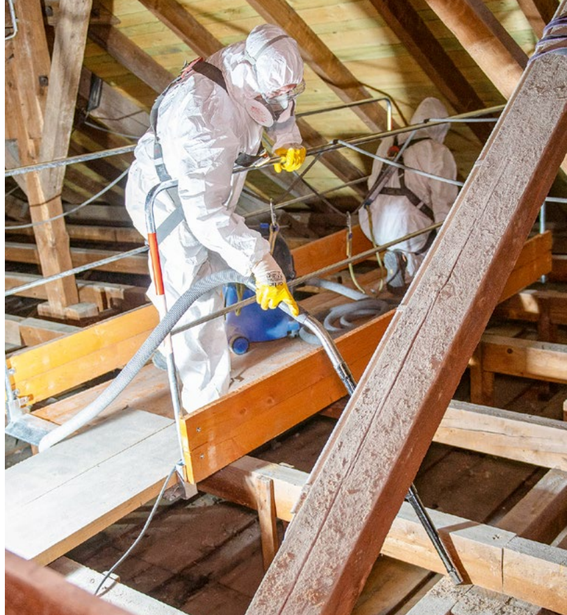
Beschäftigte, die besonders gefährliche Tätigkeiten wie die Asbestsanierung ausüben, unterliegen einer Pflichtvorsorge.
